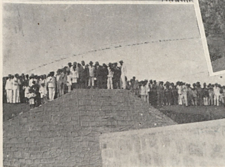
Um terceiro aspecto da barragem externa do Açude Itaberaba, na Bahia, quando visitava as obras finais o Interventor Federal, Tenente Juracy Magalhães.
